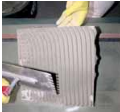
Aufgetragene Kleberschicht
