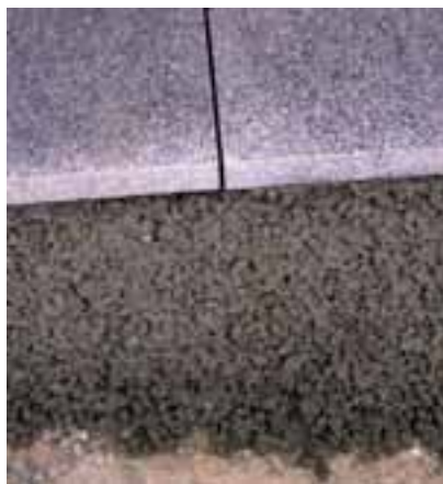
3 cm dicker Granit mit 15 cm dickem Monokornmörtel
