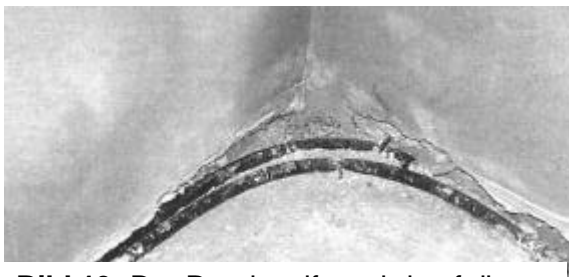
Bild 13 Der Randstreifen wird auf die Rohre gestellt werden müssen. Zwickel mit Mörtelbrücken lassen sich nicht vermeiden.
