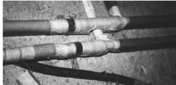
Bild 7 Die Metallschelle hält. Der Estrichleger ist doch selbst schuld, wenn er diese in seinen Estrich einbettet (Motto: „Nach mir die Sintflut“)
