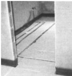
Bild 28 Rohrausgleich durch die untere Lage der Dämmschicht
