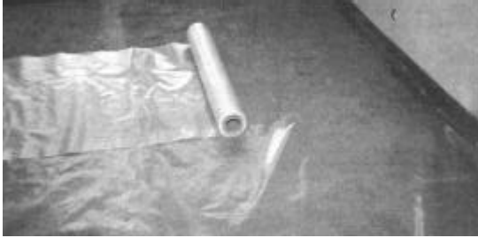
Bild 32 Eine Dampfbremse verhindert eine nachträgliche Durchfeuchtung der Trittschalldämmplatten
