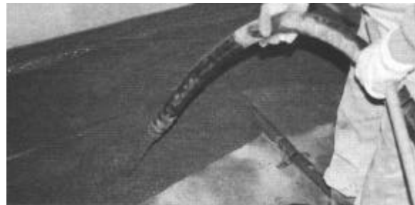
Bild 29 Rohrausgleich durch Leichtmörtelschicht mit Polystyrol-Zuschlag (Recyclingmaterial)
