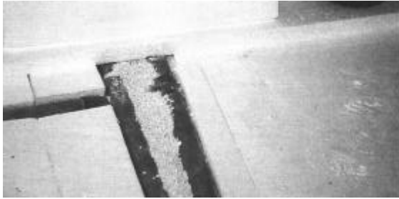
Bild 26 Die untere Lage der Dämmschicht soll die Rohre einschließlich Halterung überdecken
