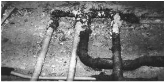
Bild 9 Die Schallbrücke ist vorprogrammiert
