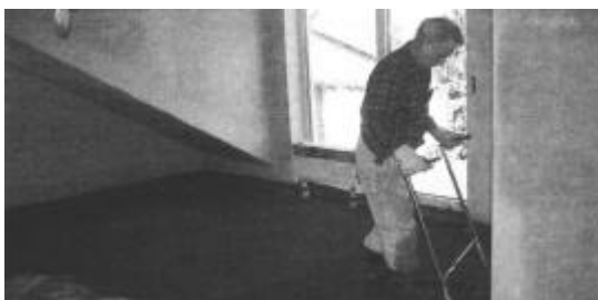
Bild 30 Der Leichtmörtel lässt sich leicht einbringen
