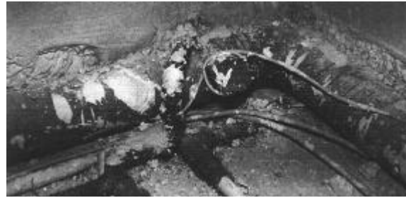
Bild 5 Wo soll hier der Randstreifen gestellt und wie ausgeglichen werden?
