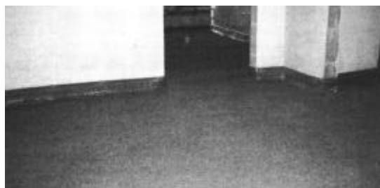
Bild 31 Der Leichtmörtel ist eine druckfeste und unebene Unterlage für die Trittschalldämmplatten
