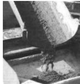
Bild 35 Der Leichtmörtel sollte nicht mit Überschusswasser hergestellt werden
