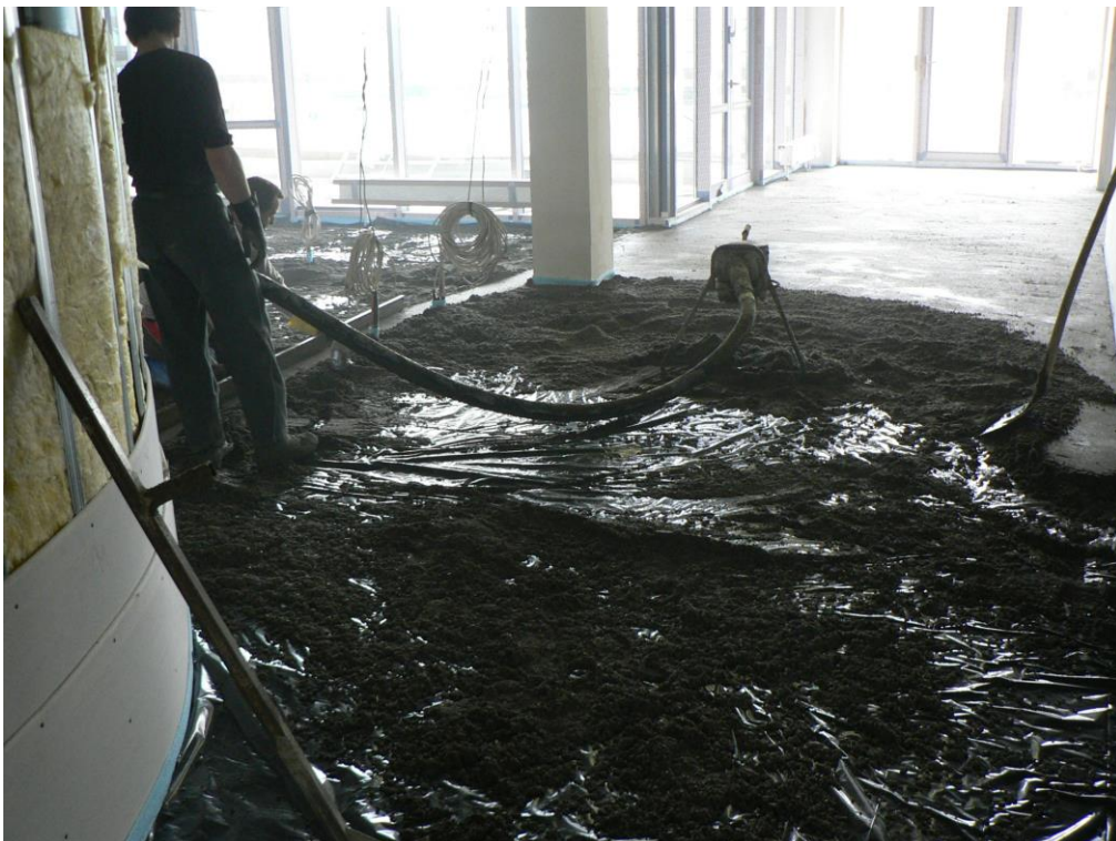
Güteschutz Estrich - Überprüfung der Estrichverlegung im Zuge der Fremdüberwachung
