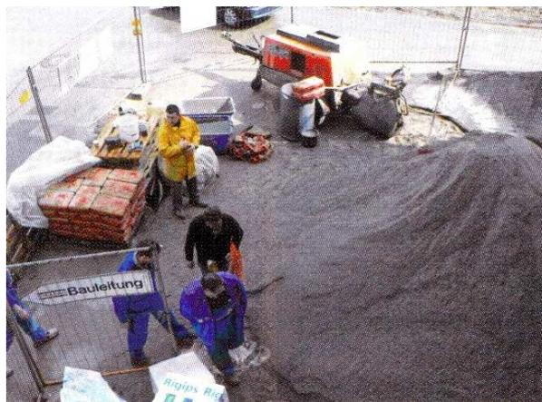
**Güteschutz Estrich - Überprüfung des Mischplatzes und des Mischvorganges bei der Estrichherstellung im Zuge der Fremdüberwachung**
