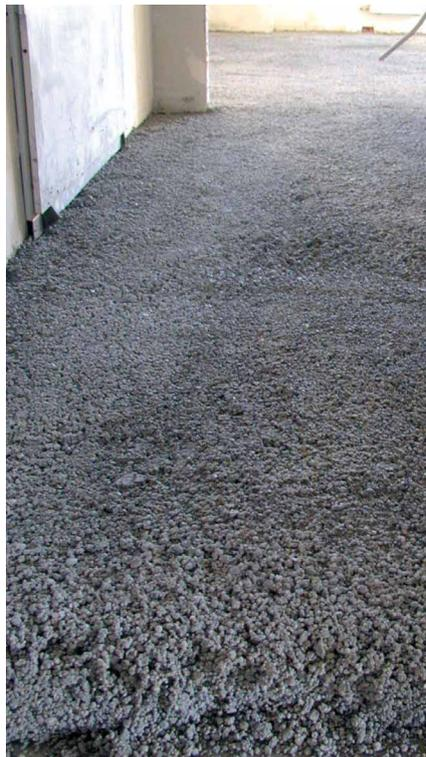
Abb. 5: Ausgleich von Installationen/Einbauten auf der Rohdecke durch Leichtausgleichmörtel
