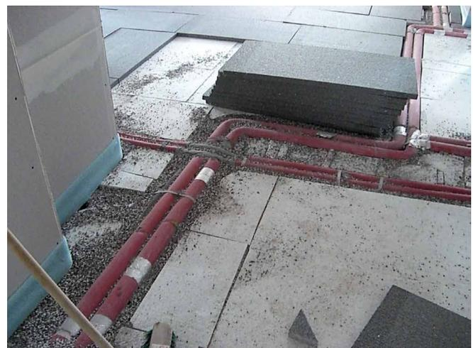
Abb. 4 a+b: Einbauten auf der Rohdecke ermöglichen keine normgemäße Verlegung der Dämmschicht
