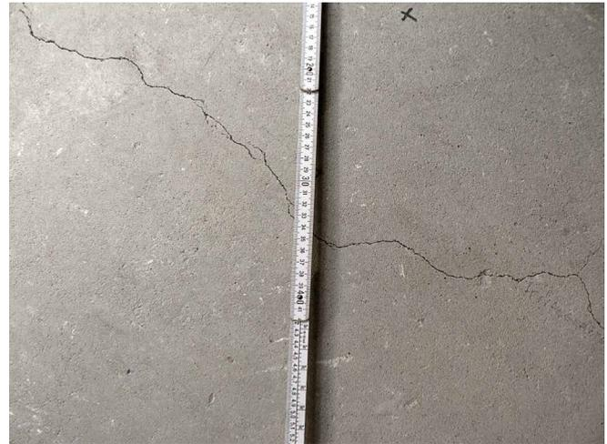
Abb. 3 a+b: Risse in Zement- und Calciumsulfatestrichen
