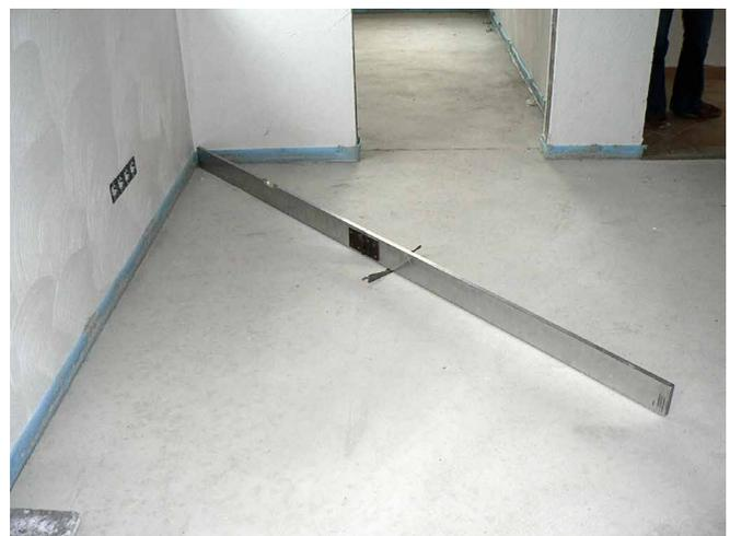
Abb. 1 a+b: Vertikale Verformungen (Schüsselung) bei schwimmenden Zementestrichen
