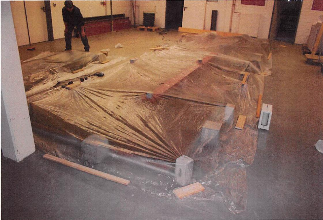
**Bild 3:** Versuchsflächen nach der Verlegung des Zementestrichs - 3 Tage
