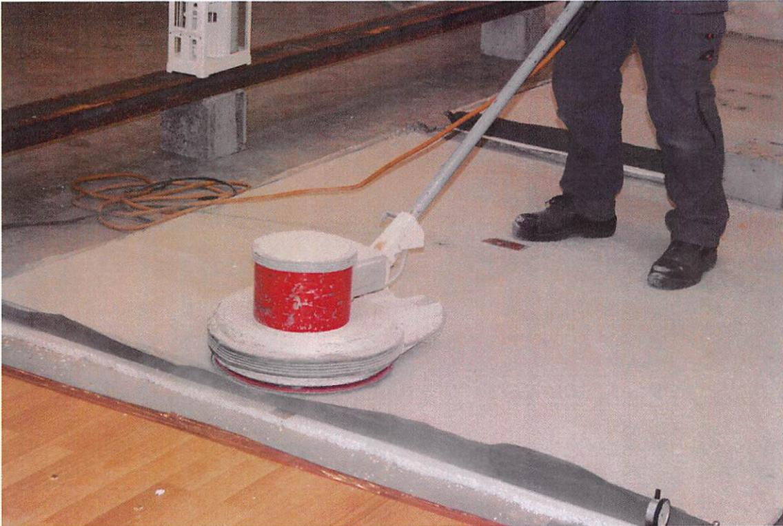
**Bild 5:** Anschleifen der Estrichoberfläche mit Schleifpapier mit 16er Korn
