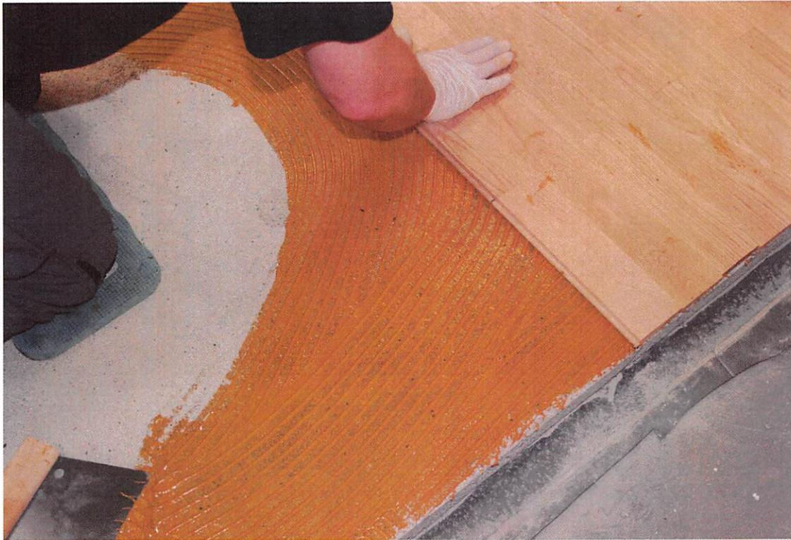
**Bild 7:** Verlegung der Parkettbeläge mit 2K-PU-Klebstoff
