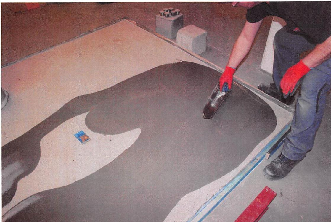
**Bild 10:** Spachteln der Versuchsflächen mit zementgebundener Spachtelmasse (Vorstrich mit wässriger Acrylat--Dispersionsgrundierung)
