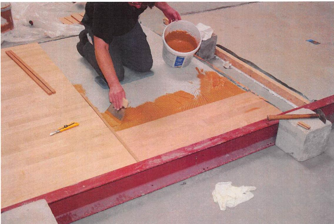
**Bild 6:** Verlegung der Parkettbeläge mit 2K-PU-Klebstoff
