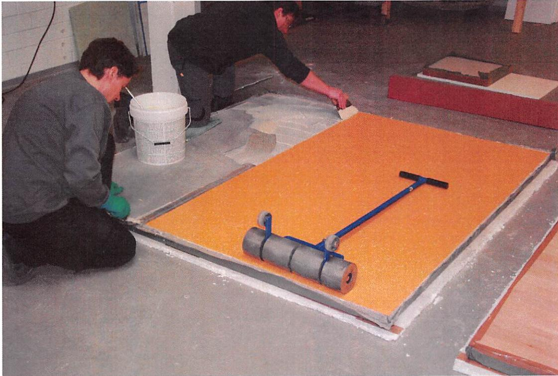
**Bild 11:** Verlegung Kautschukbelag mit Dispersionsklebstoff
