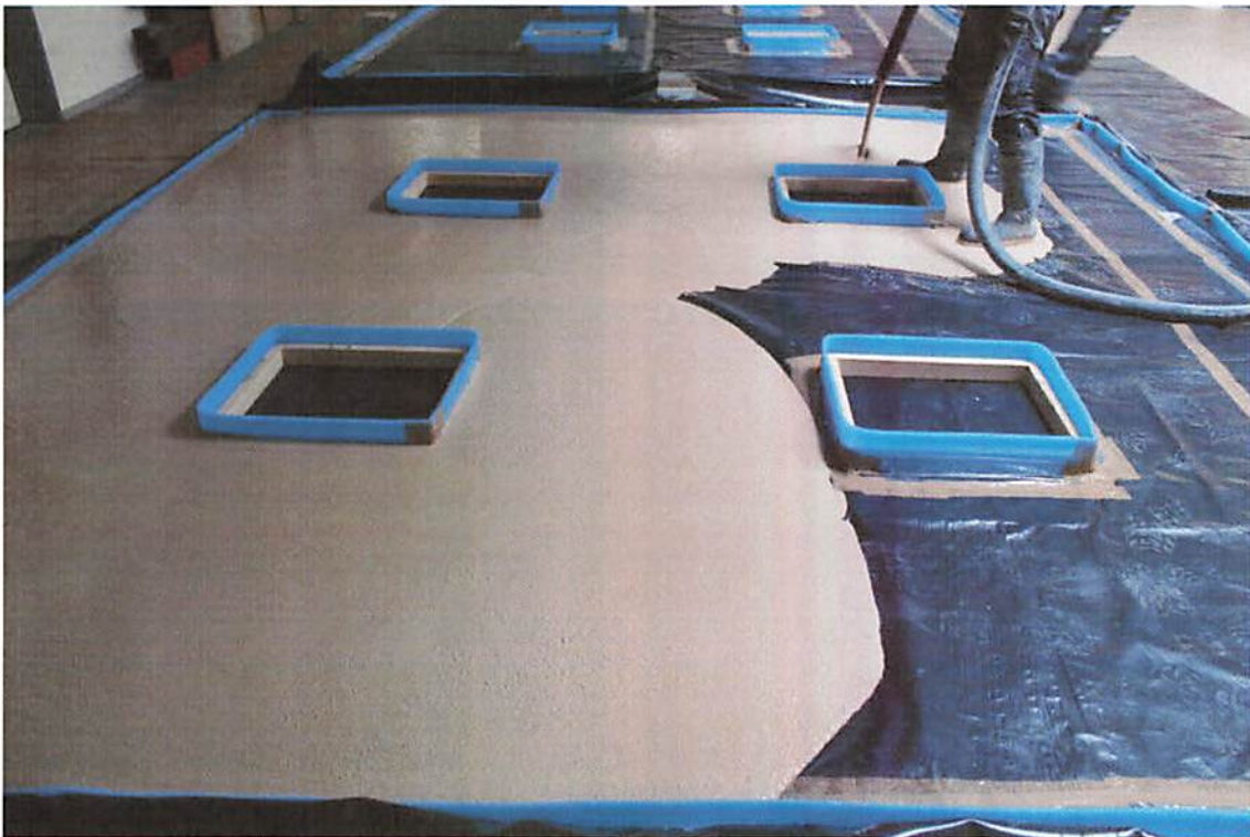
Bild 8: Versuchsfläche A – Einbau des Calciumsulfat-Fließestrichs
