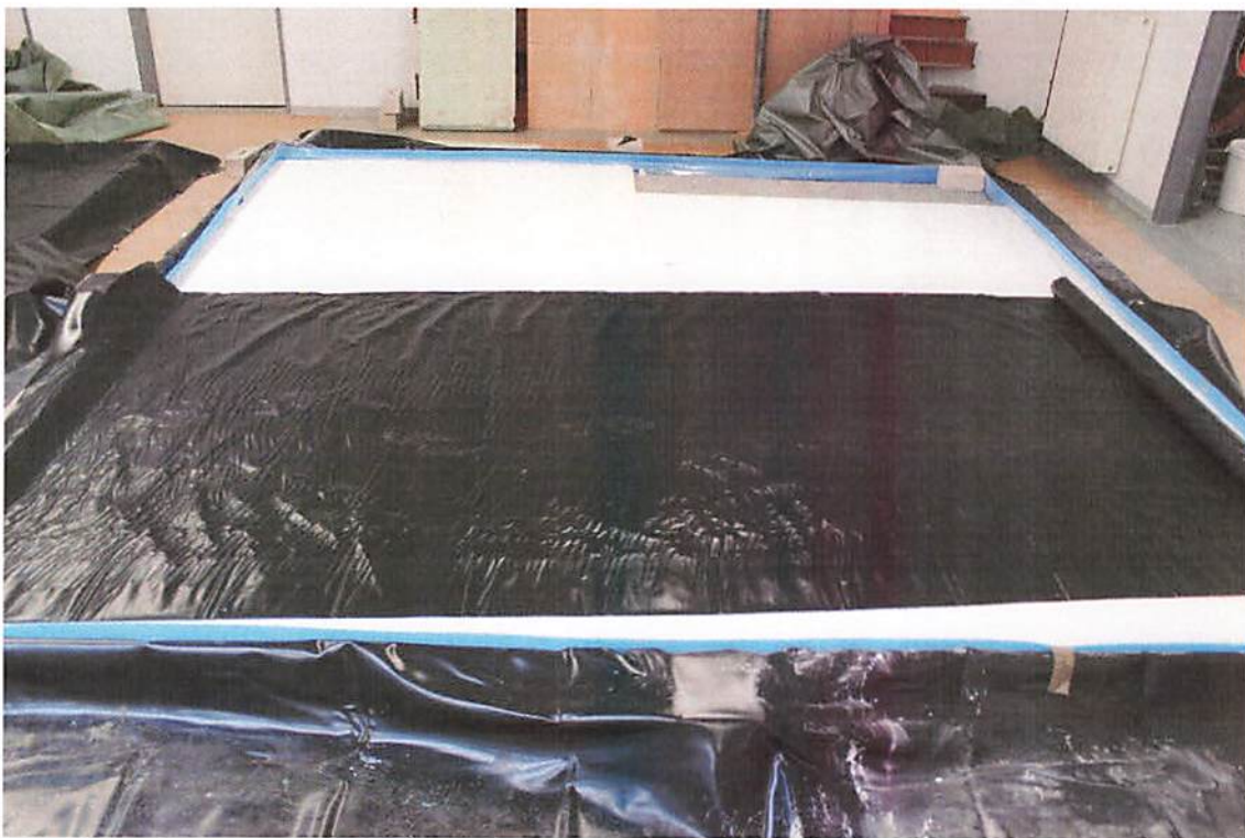
Bild 6: Einbau der EPST-Dämmplatten 20-3 mm und Abdeckung mit 0,15 mm PE-Folie
