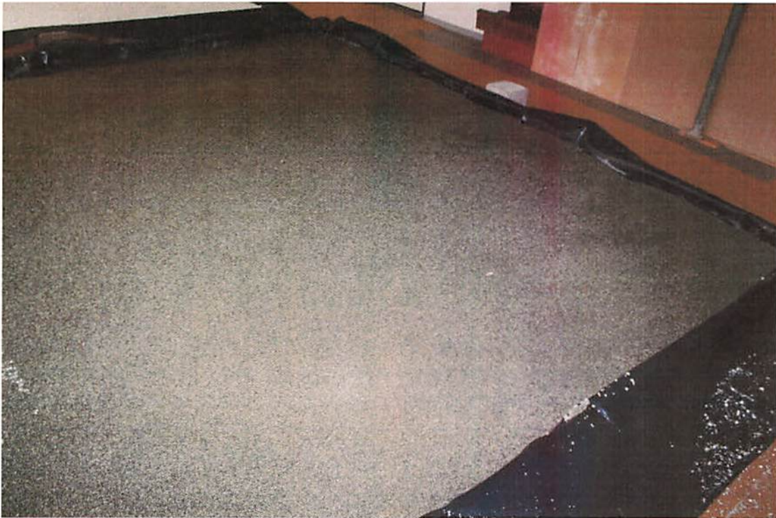
Bild 5: Versuchsfläche B nach Einbau Leichtausgleichestrich
