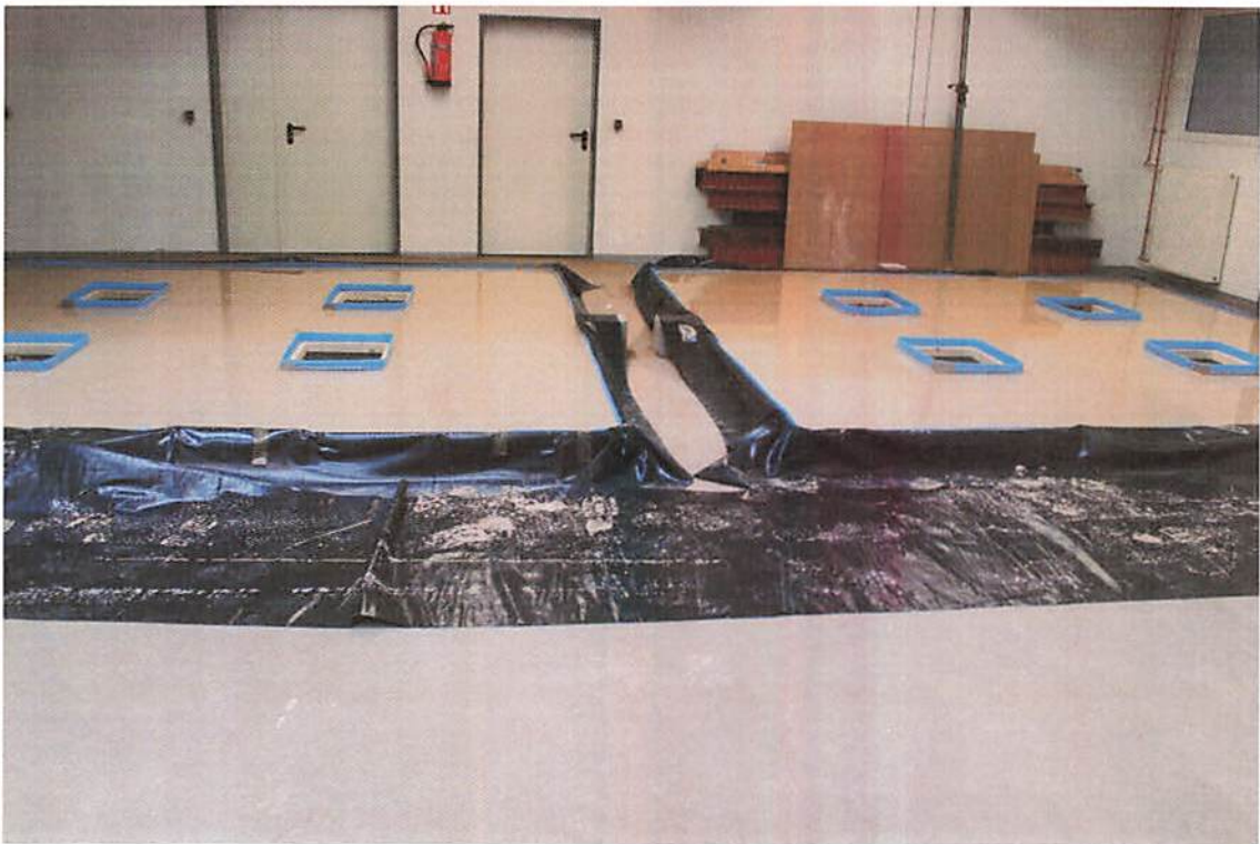
Bild 10: Versuchsflächen nach Einbau des Calciumsulfat-Fließestrichs
