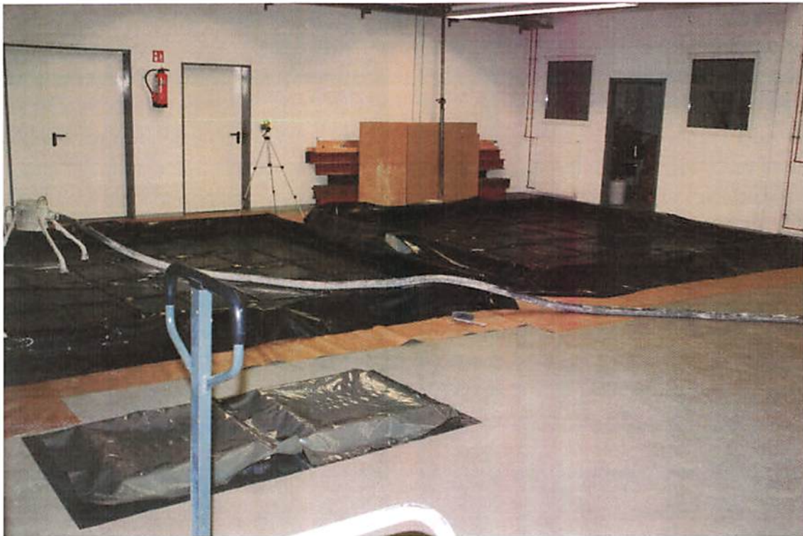
Bild 1: Versuchsflächen mit Teichfolie vor Einbau der Leichtausgleichestriche
