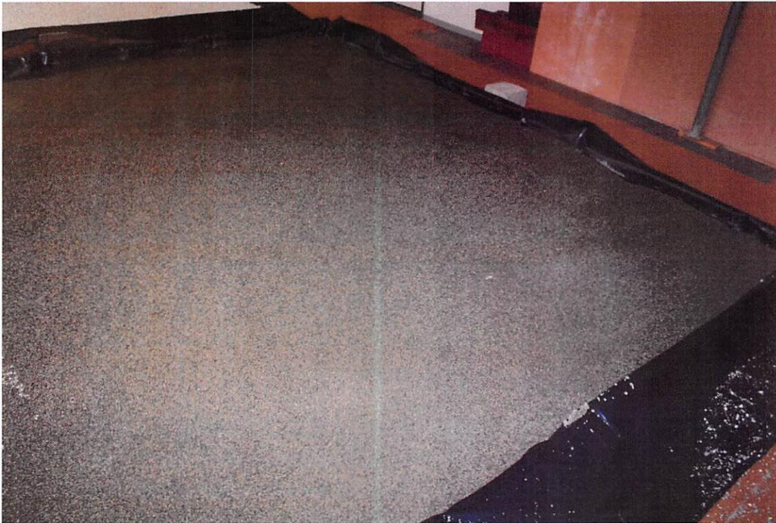
**Bild 5:** Versuchsfläche B nach Einbau Leichtausgleichestrich
