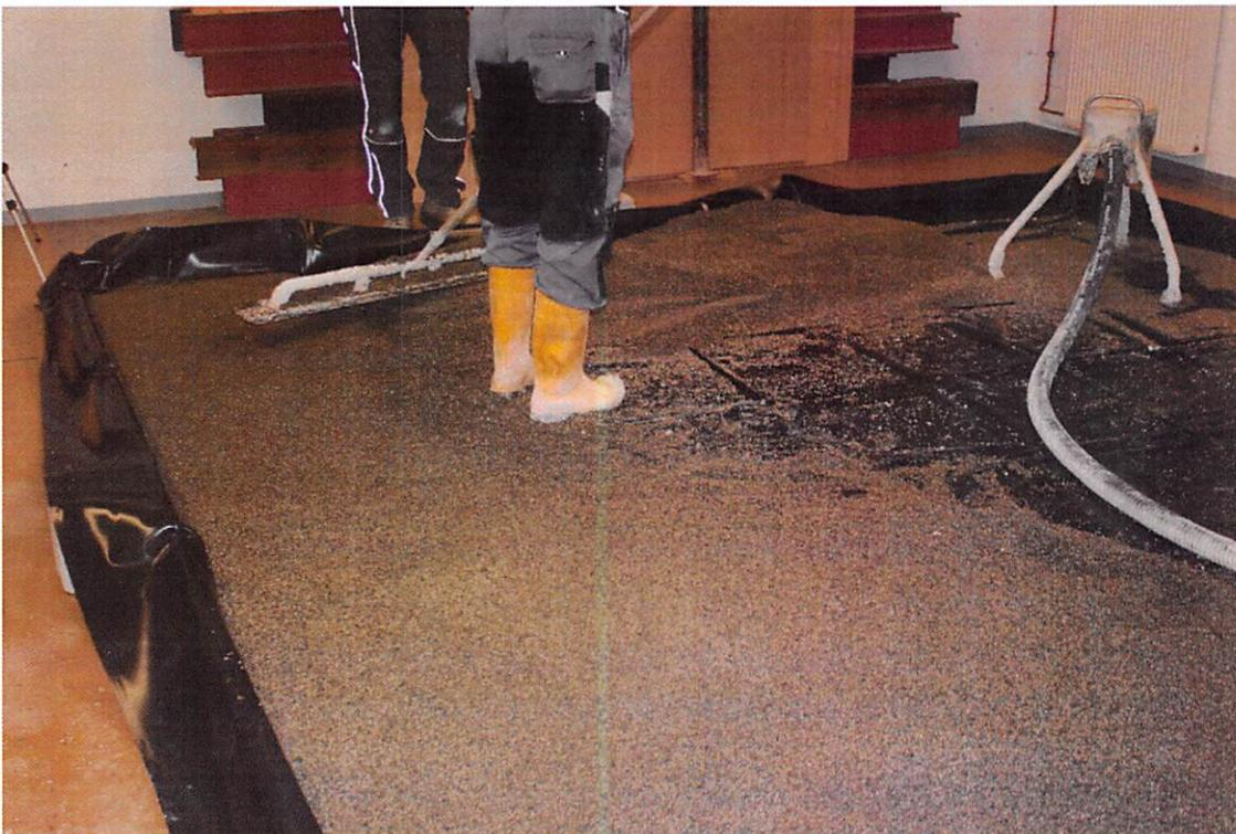
**Bild 4:** Versuchsfläche B - Einbau Leichtausgleichstrich (Material B)
