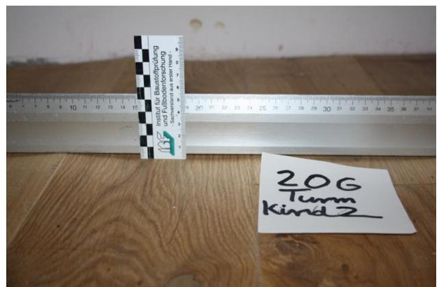
Es handelte sich um einen größeren Schadensfall, der im Zuge der Sanierung einer alten Buranlage entstanden war. Es kam zu Schüsselungen und Aufwölbungen der Holzdielen. Ausführlich wurden seitens der Sachverständigen mögliche Schadensursachen (zu feuchter Zement-Heizestrich, ungünstiges Raumklima, unzureichende Ebenheit des Zementestrichs, unzureichende Verklebung, ungünstiges Breite-/Dickenverhältnis der Holzdielen, möglicher Einfluss des Klebstoffes) diskutiert.
