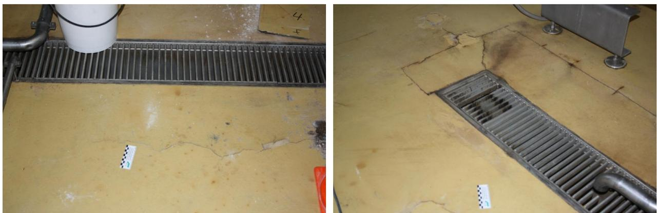
Mögliche Schadensmechanismen und Sanierungsmöglichkeiten wurden vor dem Hintergrund des neuen BEB-Leitfadens für Fußbodenkonstruktionen im nassbelasteten Lebensmittelbereich (BEB-Arbeitsblatt KH 6) vorgestellt und diskutiert. Herr Körber wies darauf hin, dass oberseitige Beschichtungen bei schwimmenden Konstruktionen und Konstruktionen auf Trennschicht zwar zur Herstellung einer flüssigkeitsdichten Oberfläche dienen, Anschlüsse und Fugenbereiche etc. aber wartungsbedürftig sind. Eine Abdichtung
