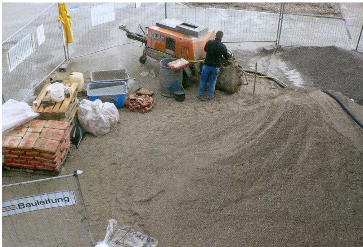
Bild 1: Die Estrichherstellung ist ein komplexer Prozess, auf den die Auswahl geeigneter Ausgangsstoffe und die Rahmenbedingungen auf der Baustelle, wie Transport, Lagerung, Mischen, Fördern und Verlegen am Einbauort, einen wesentlichen Einfluss haben.
