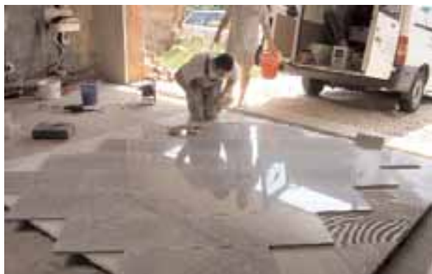
Belegung einer Versuchsfläche mit Naturwerkstein
