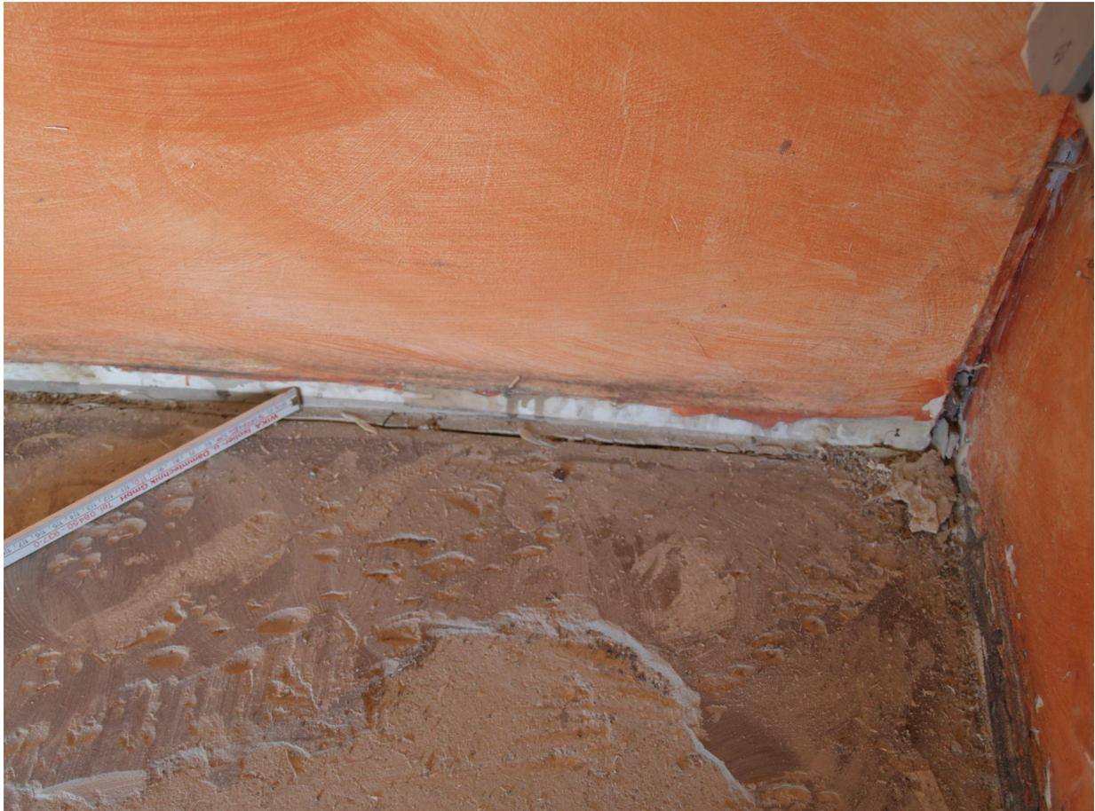
**Bild 2:** Diese Randfuge zwischen Estrich und Wand wurde mit einer Spachtelmasse oberseitig geschlossen. Schallbrücken und Risse durch Zwängungen sind die Folgen.
