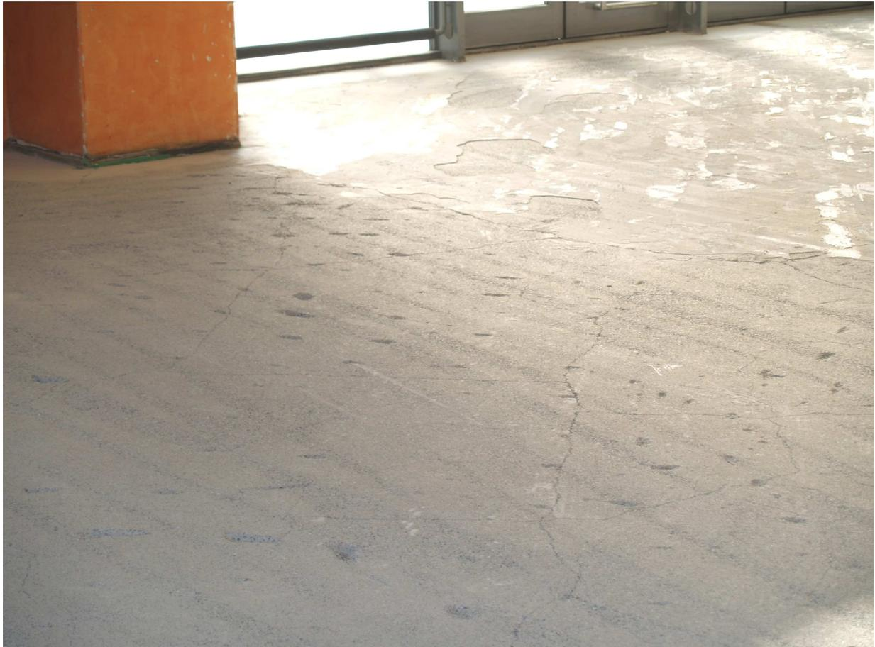
**Bild 1:** So sehen oft alte Estriche nach dem Entfernen des Bodenbelags aus, mit Löchern, Rissen und Resten einer Spachtelmasse. Der Fliesenleger muss nun prüfen, ob dieser Estrich noch als Untergrund für einen neuen Fliesenbelag taugt und ihn entsprechend vorbereiten.
