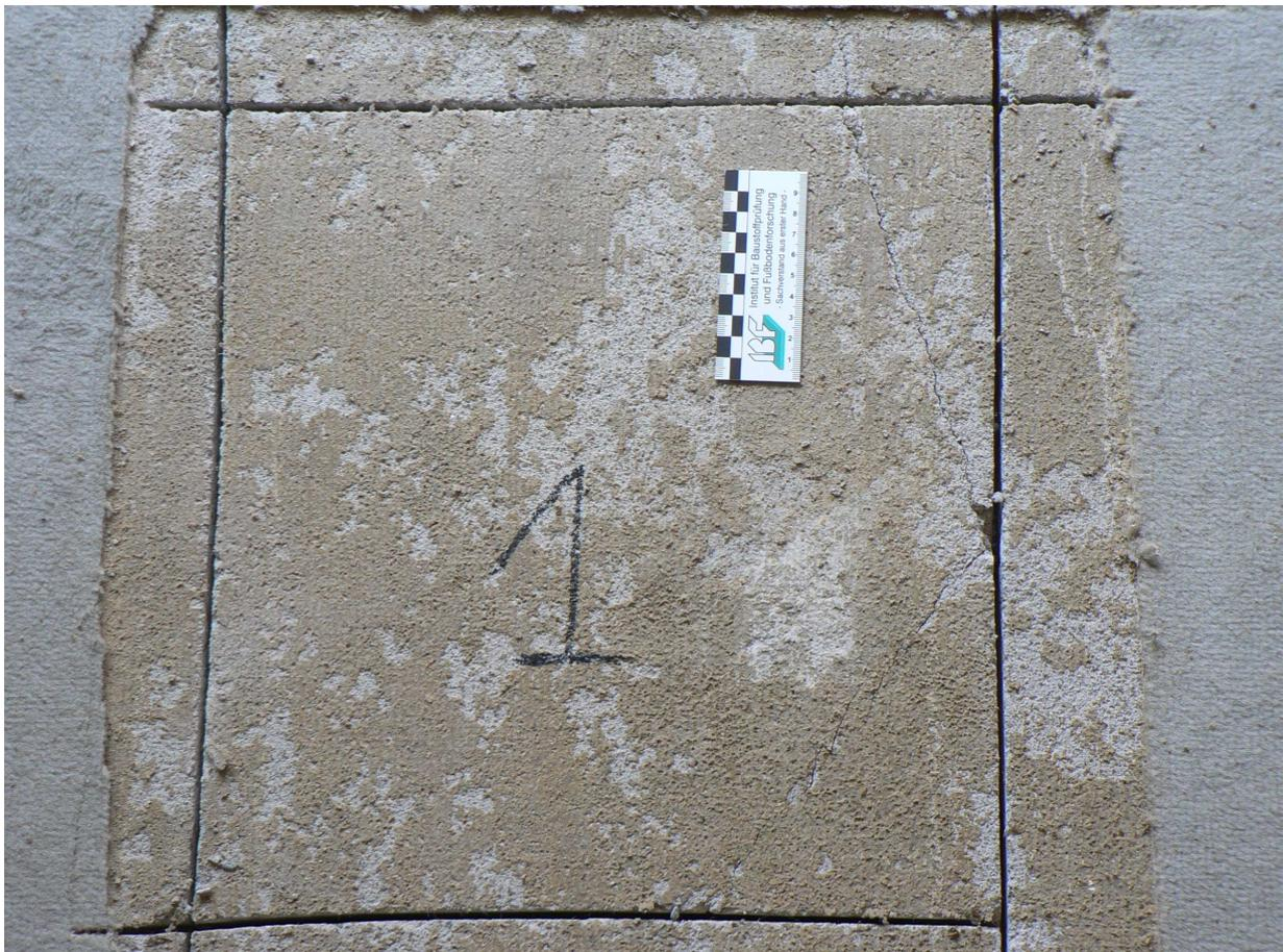
**Bild 3:** Ist dieser Estrich, auf dem zuvor ein Teppichboden lag, trotz Rissen noch tragfähig? Und was waren die Ursachen für die Risse? Um diese Fragen zu klären wird eine Estrichplatte entnommen, die Öffnungsstelle begutachtet und eine Bestätigungsprüfung durchgeführt.
