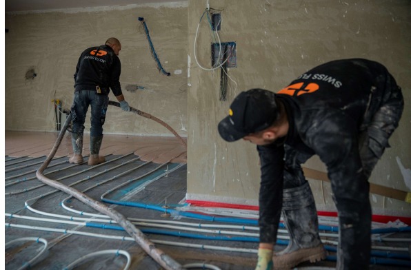
Referenz: Diverse Baustellen Swiss Floor
