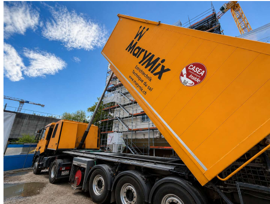
Referenz: Mixmobil Swiss Floor, Baustelle Biel
