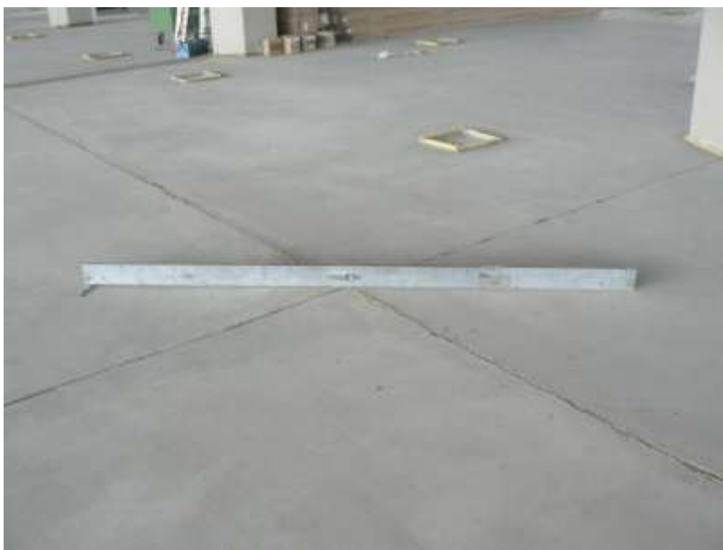
Fugen in einem Estrich auf Trennschicht
