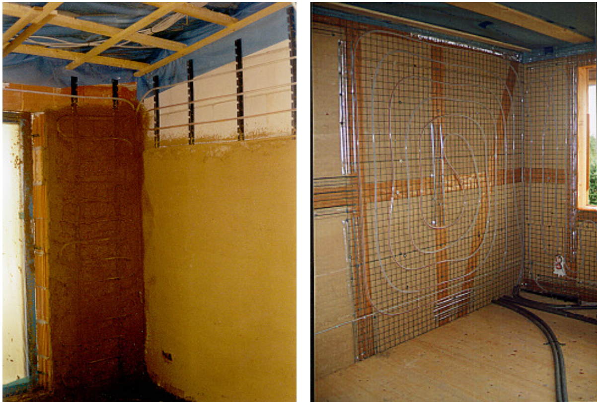
Bild 1.5: Wandheizung in einem Lehmputz (links) auf Schiene bzw. in einer Holzkonstruktion auf einer Rohrträgermatte
