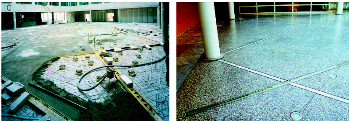
Bild 3.12 Einwandfreie Fugenplanung und –ausführung dank durchgängiger Schnittstellenkoordination (CityCenter Dresden)
