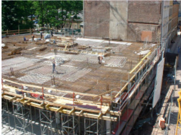
Bild 2.6: Rohrregister in Deckenmitte - Betonkernaktivierung
