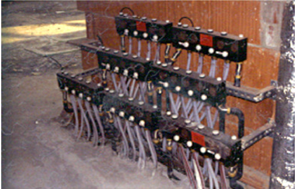
Bild 3.7 Planungs- und Ausführungsfehler: unnötige Heizrohrkonzentration
