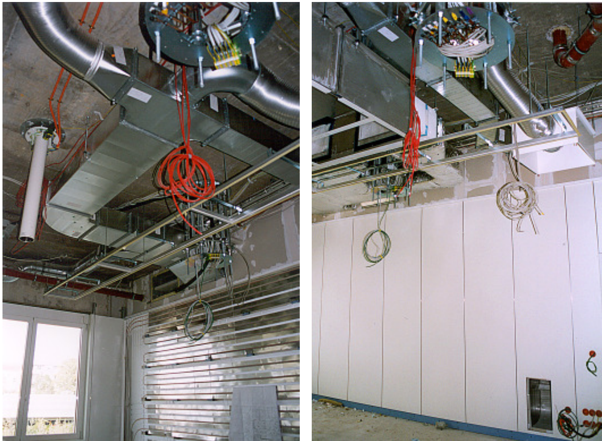
Bild 1.7: Trockenverlegte Wandheizung (velta siccus wall) im OP-Bereich des Krankenhauses St. Elisabeth in Leipzig
