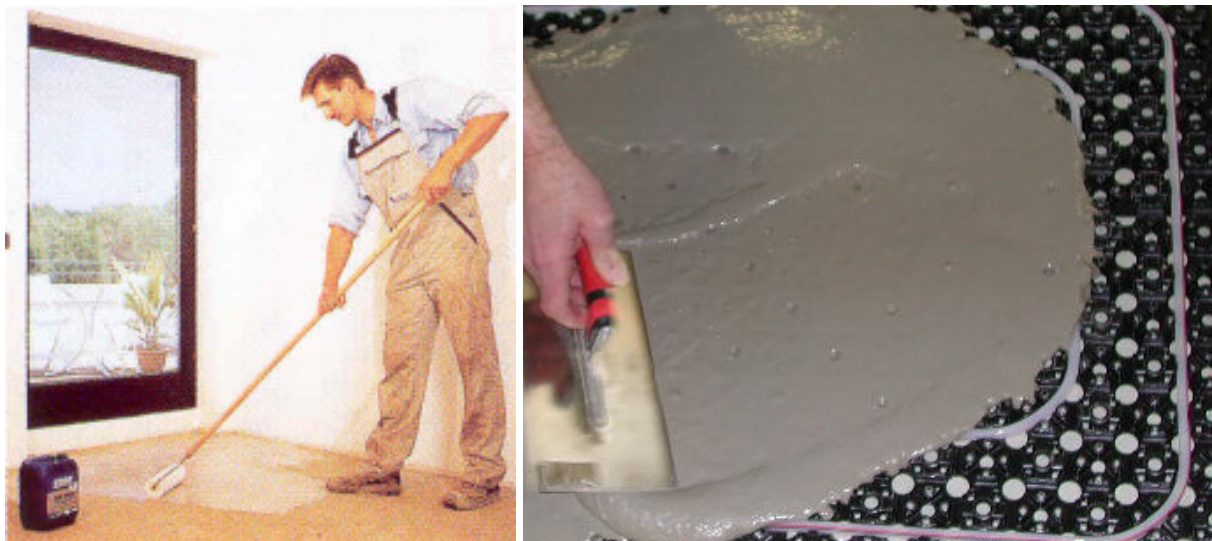
Bild 1.12: Vorbehandeln des Untergrundes und Einbringen der Ausgleichsmasse durch den Bodenleger
