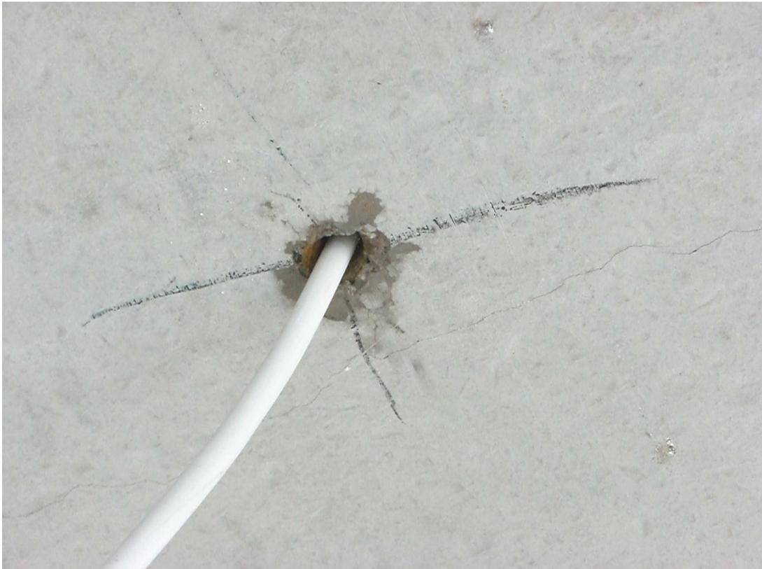
**Bild 1:** Elektrokabel tritt an der Unterseite der Rohdecke aus dem nachträglich angelegten Bohrloch aus
