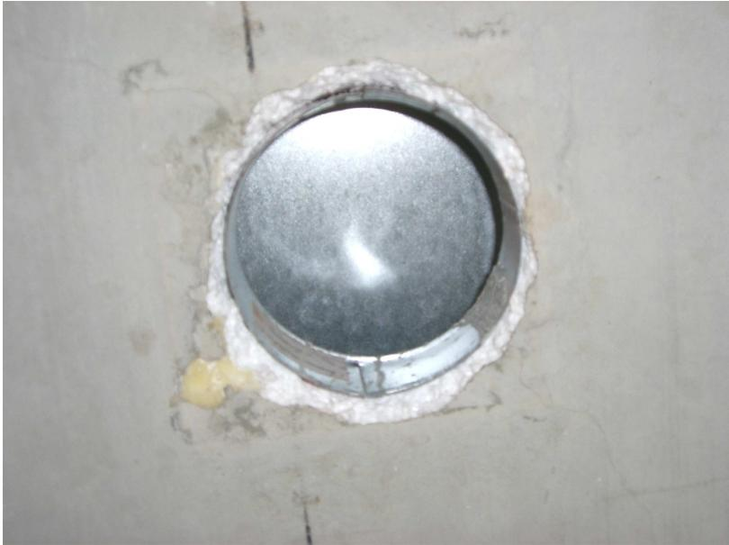
**Bild 3:** Abluftkanal oberseitig auf der Rohdecke verlegt
