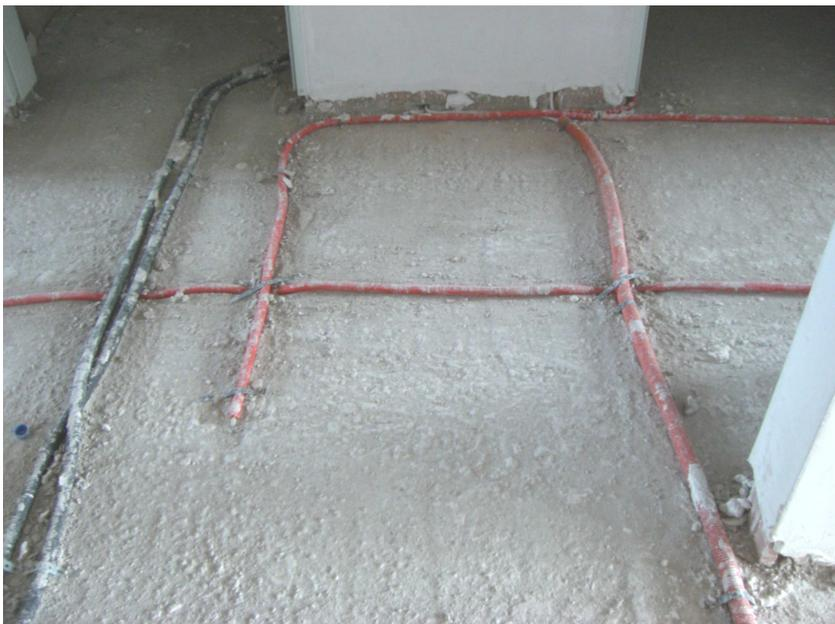
**Bild 4:** Elektrokabel auf der Rohdecke
