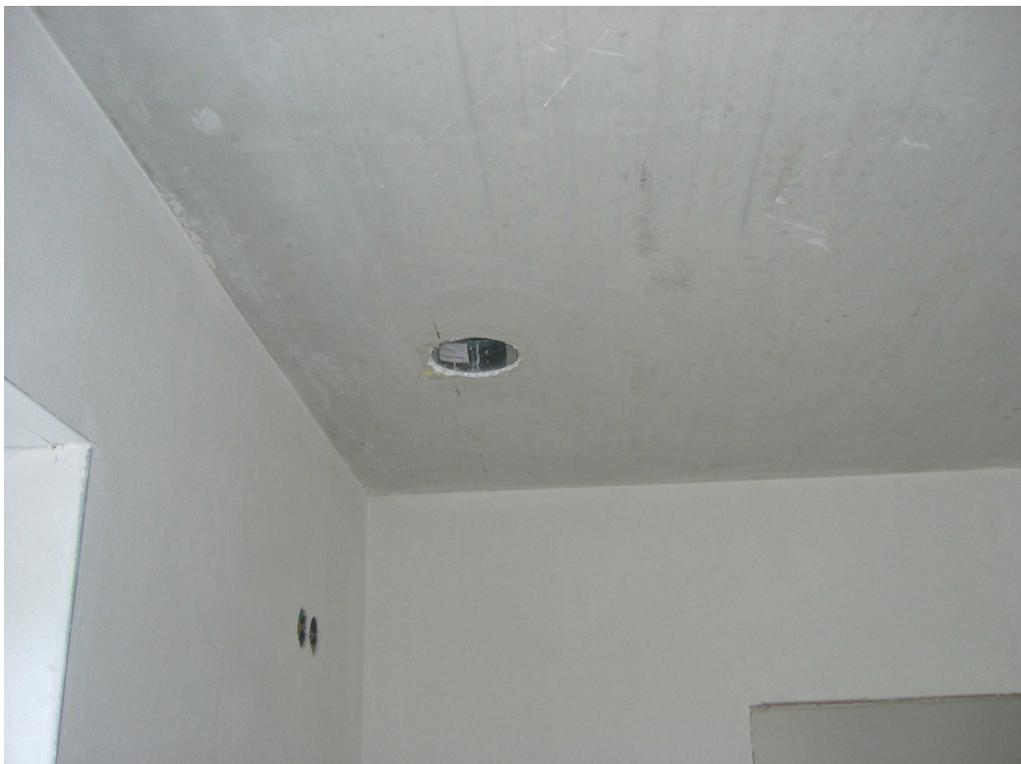
**Bild 2:** Blechaussparung zur Aufnahme eines Abluftgerätes in der Stahlbetondecke
