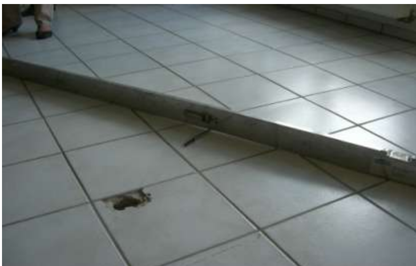
Verformungen und Rissbildungen in einem Zementestrich mit Fliesenbelag trotz Verwendung eines verformungsfähigen Dünnbettmörtels
