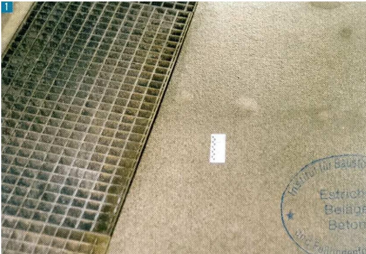
**Bild 1:** Diese Reaktionsharzbeschichtung in einer Autowaschanlage hat Blasen ausgebildet.
